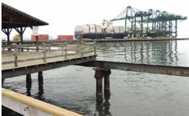
Pier do Porto Itapoá
